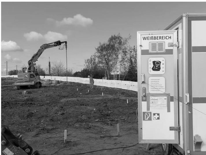
**Abbildung 3** Bohrlochsondierungen im kontaminierten Bereich mit mobiler Schwarz-Weiß-Anlage.
