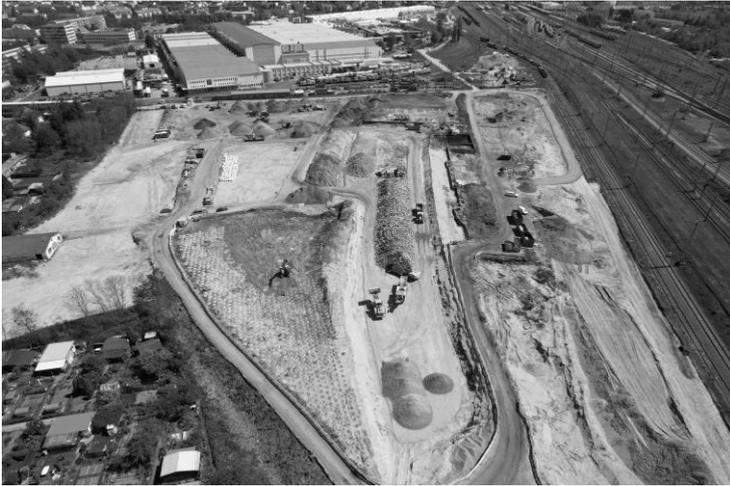
**Abbildung 4 Fortschritt Baufeldfreimachung für die nächste Bauphase mit Bohrlochsondierungen im kontaminierten Bereich der ehemaligen Leuchtgasanstalt**
