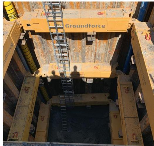
Für die Baugrubensicherung zur Bergung der 250 kg schweren Fliegerbombe lagen in diesem Beispiel von der Anfrage bis zur Freimeldung nur etwa zehn Wochen, bei einer Mietdauer von acht Wochen. Ein erfolgreicher Einsatz des modularen hydraulischen Verbausystems von Vp Groundforce bei der Kampfmittlräumung.
